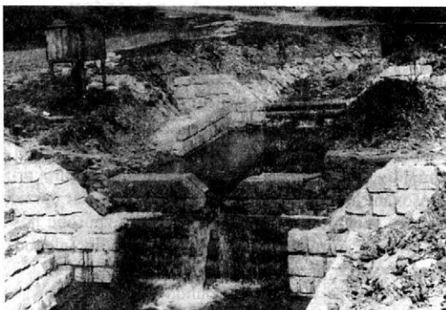
2. Měření odtoků na přítoku Kýchově – The measuring of runoff rates in a tributary of the Kýchová stream
