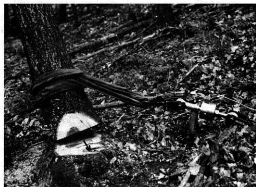
5. Integrovaný způsob kácení pomocí tažného lana – Integrated felling with skidding line
