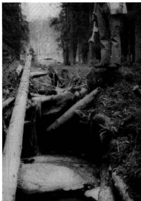
9. Totální odplavení půdy z lanokové trasy následnou vodní erozí - Complete washing-away of the soil from the cableway track as a result of subsequent erosion
