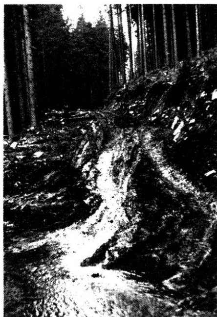
4. Průtok stálé vodoteče přes rozestavenou svážnici - The flow of a permanent stream across the slope road under construction
