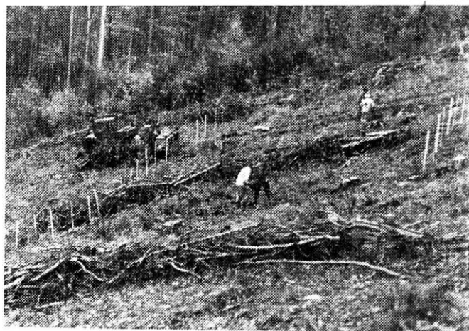
4. Pohled na pracoviště speciálního kolového traktoru LKT 81 se zabezpečovacím zařízením, elektroagregátem a třemi vrtacími soupravami při práci ve svahu — View of the working lot of the LKT 81 special wheel tractor with the security device, electroaggregate and three boring sets working on a slope
