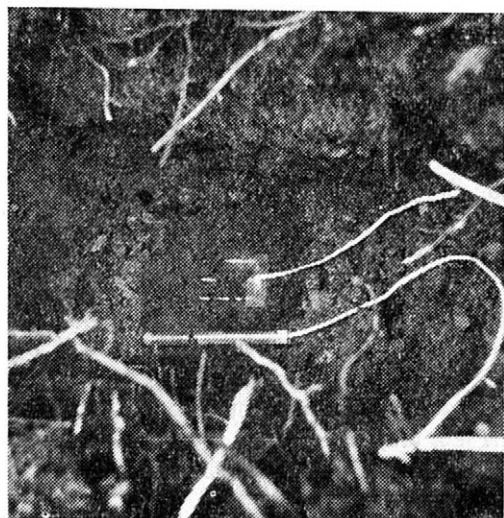
7. a — uložení snímačů vlhkosti a teploty do půdy; b — vyvedení káblíků čidel na krajnici. — a — installation of hygrometric and thermometric sensors in soil; b — fixation of sensor cables to the road shoulder
