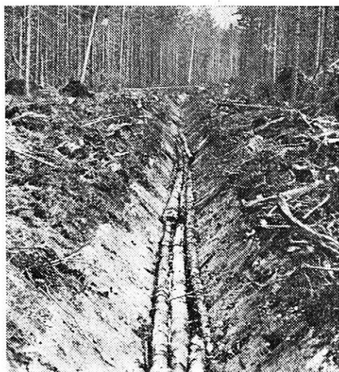
13. Příkop vyhloubený trhavinami. — A ditch made by explosives
