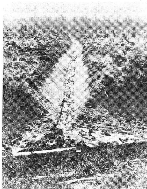
11. Hloubení příkopu s krabicovou nepravidelnou lopatou. — Ditching by a box-shaped unprofiled shovel
