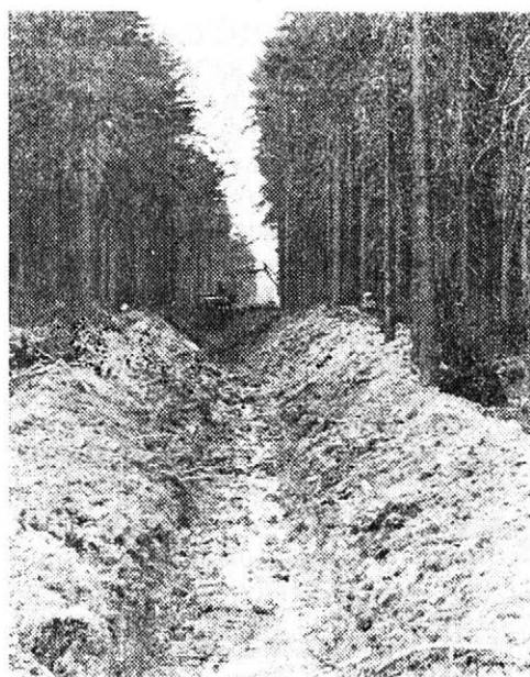
11. Hloubení příkopu s krabicovou nepravidelnou lopatou. — Ditching by a box-shaped unprofiled shovel
