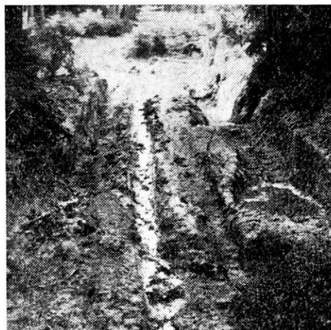
7. Měkká lesní cesta zničená vysokou frekvencí jízdy těžkých vozidel. — A forest road with unsolidified surface destroyed by the frequent rides of heavy-duty machines
