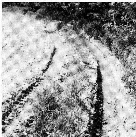
7. Měkká lesní cesta zničená vysokou frekvencí jízdy těžkých vozidel. — A forest road with unsolidified surface destroyed by the frequent rides of heavy-duty machines
