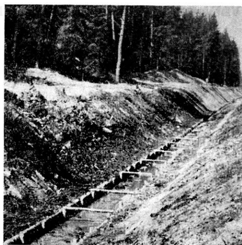
1. Zcela zarostlý hlavní odvodňovací příkop před meliorací. — Fully clogged main drainage ditch before reclaim
