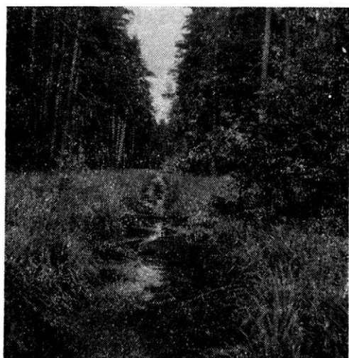
1. Zcela zarostlý hlavní odvodňovací příkop před meliorací. — Fully clogged main drainage ditch before reclaim
