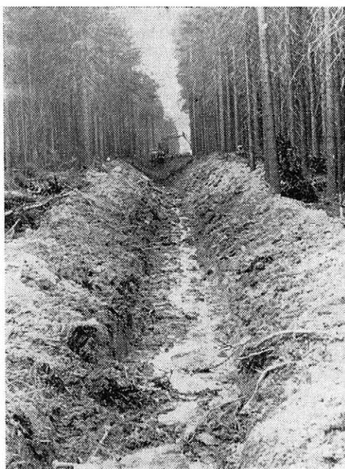
6. Odvodňovací příkop hloubený s použitím profilové lopaty. — A drain ditch built with a profiled-shovel excavator
