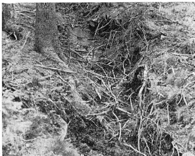
8. Detailní záběr odvodňovacího příkopu hloubeného technologií s použitím trhavin se stagnující povrchovou vodou. — A detail view of a drain ditch excavated by means of explosives; stagnant surface water
