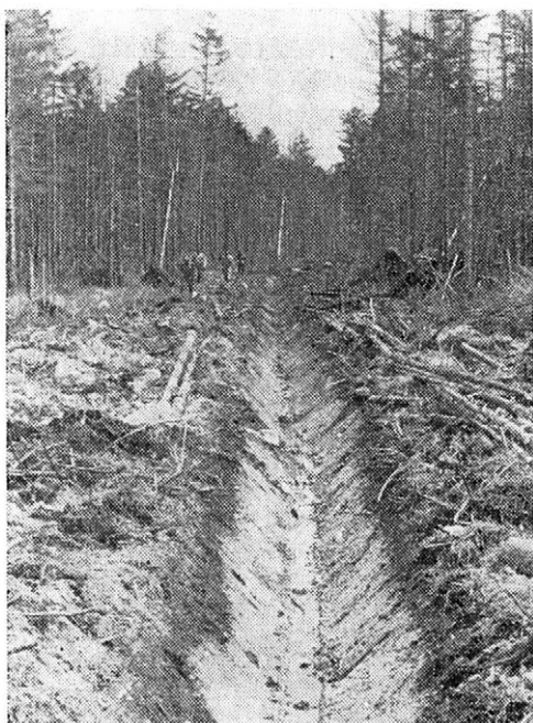
6. Odvodňovací příkop hloubený s použitím profilové lopaty. — A drain ditch built with a profiled-shovel excavator
