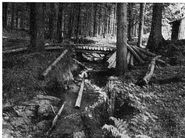
1. Provizorní most z kulatiny v trase přibližovací cesty. — Provisional bridge made of round wood on the skidding road.
