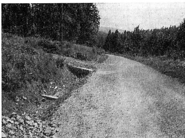
2. Příklad budování příkopů u lesní silnice. — An example of digging ditches along the forest road
