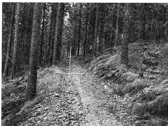
7. Výkopové svahy svážnic byly vytvořeny buldozerem bez dalších úprav. — Cutting gradients of the sloping roads were done with bulldozers with no further treatment
