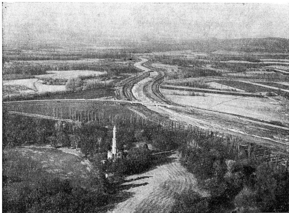
6. Letecký pohled na aluvium Dyje po dokončení úprav. V popředí Lednický park, lesy převážně LZ Břeclav (polesí Horní les), pod Pálavskými vrchy zčásti i LZ Židlochovice (polesí Bulhary) s budoucí zátopou Pálavských jezer. Letecké snímky Spurný, Rekrafo Brno. — An aerial view of the alluvium of the Dyje after finished regulation work. Front: Lednice park, forests mostly belonging to the Břeclav Forest Enterprises (Horní les forest district), under the Pálava hills; part of the forests also belonging to the Židlochovice forest district (Bulhary forest district) with region which is to be flooded by the Pálavské lakes. Aerial photos by Spurný, Rekrafo Brno
