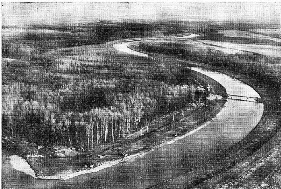
5. Letecký pohled na dokončený úsek úprav Moravy na LZ Břeclav s parametry oblouků pro lodní dopravu. Na obzoru hodonínská elektrárna. — An aerial view of a finished section of the regulation of the Morava river at the Břeclav Forest Enterprise with parameters of arches for boat transport. On the horizon: the Hodonín power station
