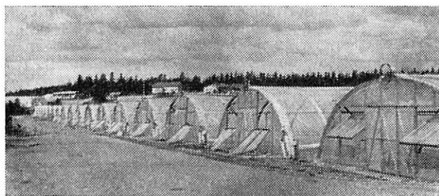
3. Soustava polyetylénových skleníků pro pěstování semenáčků ve školce Imari. V každém skleníku je pěstováno 300 000–400 000 semenáčků ve Finnpotech. Větrání skleníků vyklápěním předních stěn a rovněž srolováním stropní části fólie
