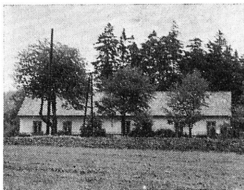
1b. Dělnický domek Lísek čp. 60 z roku 1913, pohled, stav v roce 1970. — Workers' house Lísek no. 60, from 1913 view, condition in 1970
