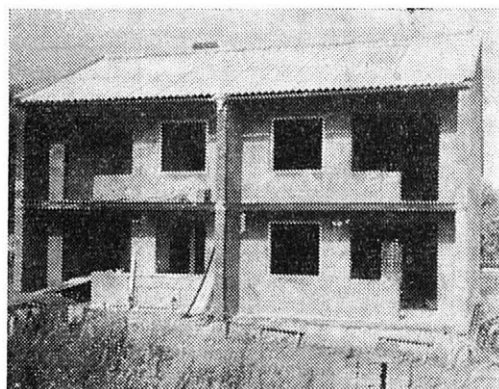
4b. Pohled na rozestavěný domek (typ řadového domku pro zemědělce) z třískocementových tvárnic v Křenovech v roce 1973, LZ Horšovský Týn, SL Plzeň. — View on an unfinished semi-detached house (type of ordinary house for agriculturists) from chip-cement moulded bricks Křenovy in 1973, FE Horšovský Týn, SF Plzeň
