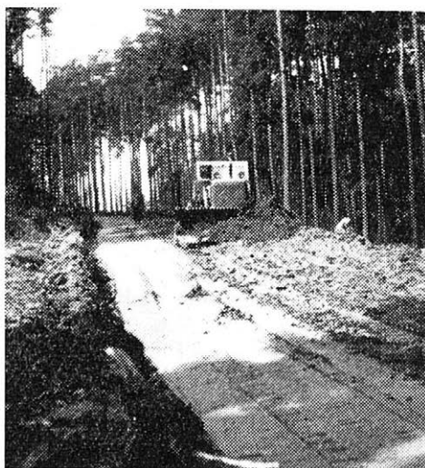
9. Dozer D 493A (SSSR) s neseným rozrývačem zemin (výrobce Strojírny státních lesů Slov. Lupča) při profilování zemní pláně. Stavební závod Plzeň. — Dozer D 493A (SSSR) with mounted earth ripper (producer Engineering works of State forests, Slov. Lupča) in shaping of earth formation. Construction factory Plzeň
