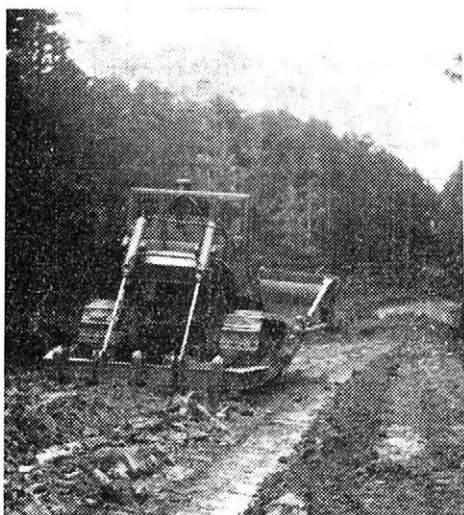
9. Dozer D 493A (SSSR) s neseným rozrývačem zemin (výrobce Strojírny státních lesů Slov. Lupča) při profilování zemní pláně. Stavební závod Plzeň. — Dozer D 493A (SSSR) with mounted earth ripper (producer Engineering works of State forests, Slov. Lupča) in shaping of earth formation. Construction factory Plzeň
