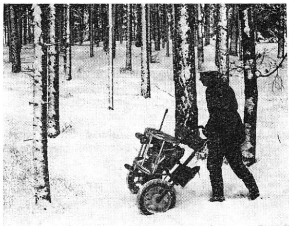
5. Šplhací pila KS-31 v transportní poloze. — Climbing saw KS-31 in transport position
