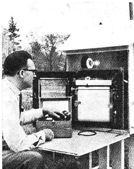
5. Měření podmínek prostředí potencio-metrem. Snímky Skoupý
