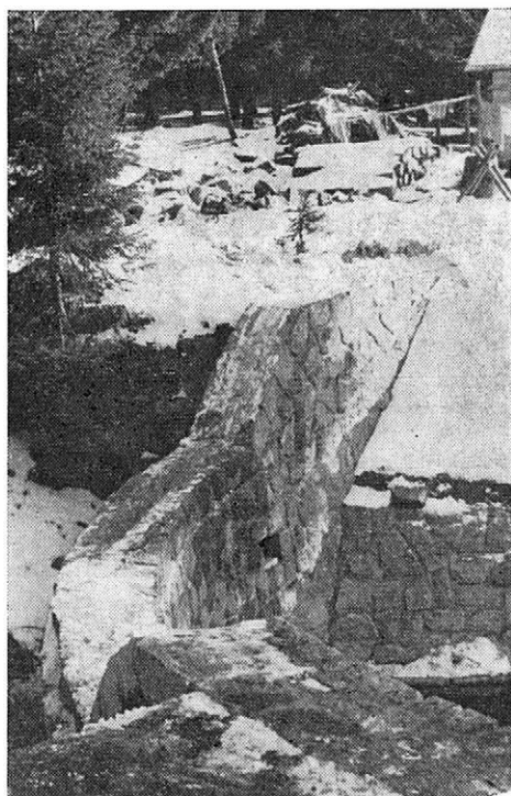
11. Klenbová přepážka na Kamenici v Harrachově. — Arch dam in the Kamenice torrent at Harrachov
