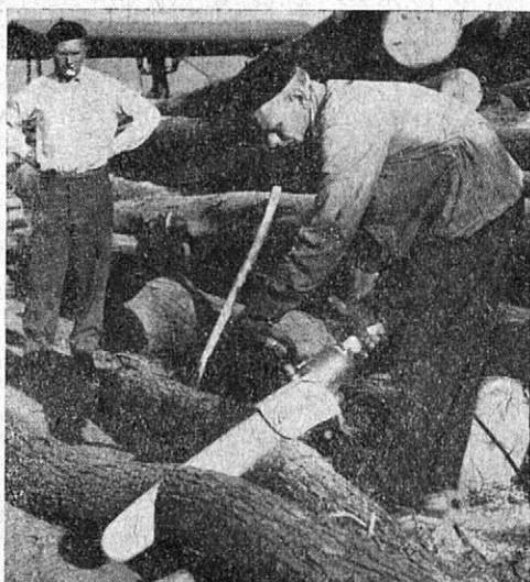
20. Manipulace na skladě pomocí jednomužné pily Elbobr
