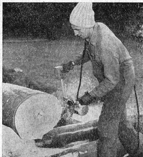
19. Zjišťování řeznosti pily CNIIME-K6
