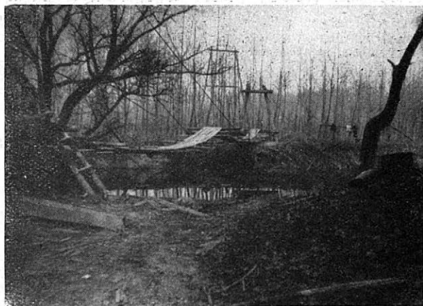
16. Lanová lávka ve výstavbě. Snímek Petr
