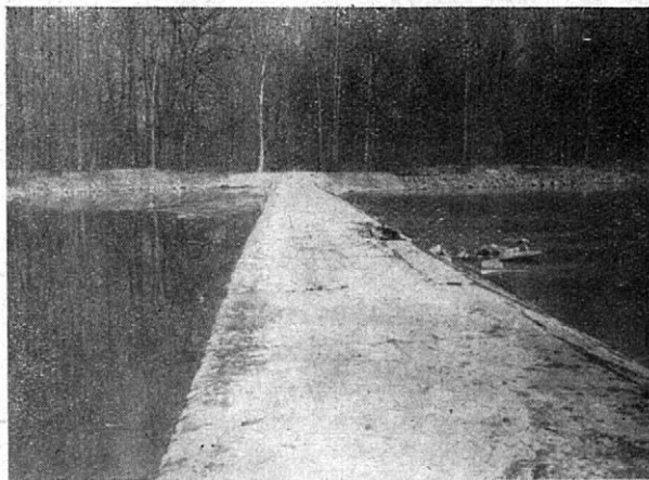
3. Hráz přes rameno Dunaje
