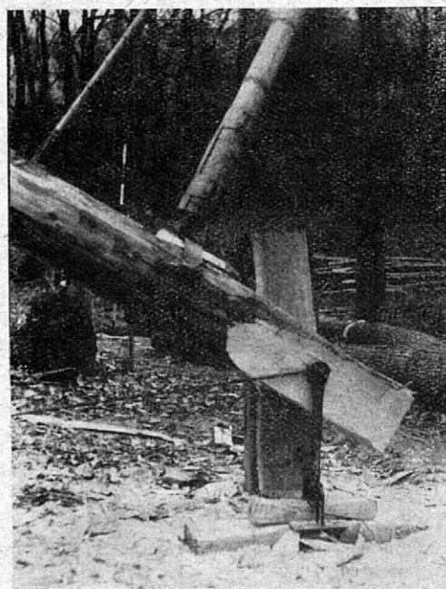
12. Vzájemné uchycení podpěry, stožáru a patky
