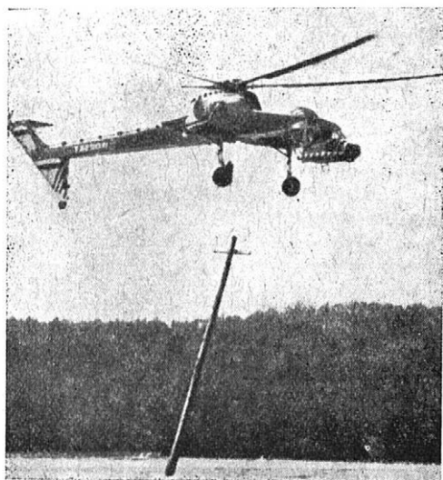
6. Vrtulník S-60 fy Sikorsky (USA) o nosnosti 6 t nazývaný „létající jeřáb“. Snímek Cermak a Lloyd
