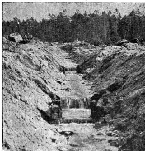
7. Odpad zpevněný kamennými prahy a dřevěnými pražci. Medvědí skála, LZ Janov
