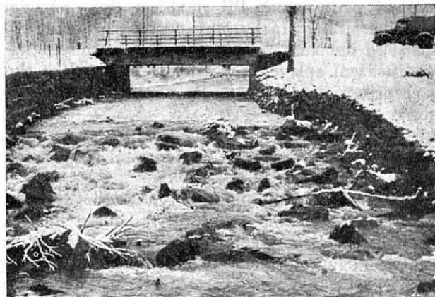
11. Rekonstrukce jezu balvanitým skluzem na Stříbrníku u Frýdlantu n. O. Snímky Jarařabáč
