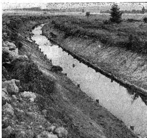
5. Hlavní odpad zpevněný pohozením a laťovým plůtkem. Výsluní I, v km 1,150. LZ Chomutov
