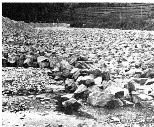
9. Kamenitý pohoz dna na Vadičovce 10. Pokusná úprava Lomné kamenným záhozem
