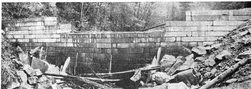
4. Přepážka z betonových prefabrikátů na Lomné
