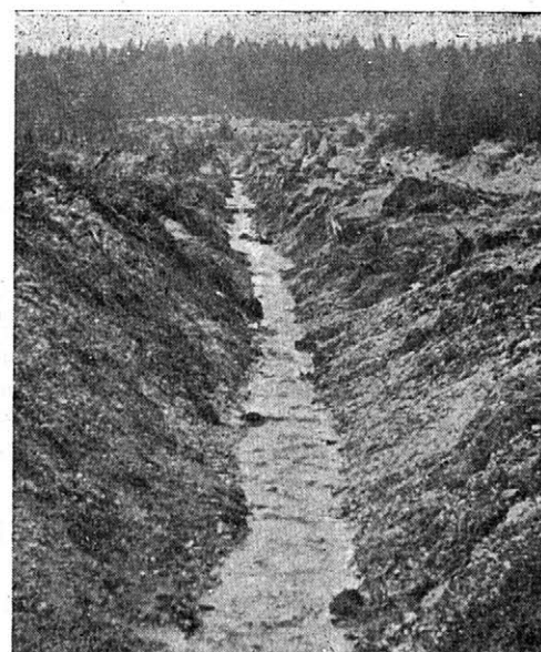
8. Sběrný příkop vedený šikmo na vrstevnice citlivě reaguje na nadměrné množství srážek. Medvědí skála, LZ Janov. Snímky Macoun
