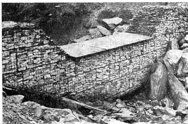
3. Drátokamenná přepážka na Radvanově
