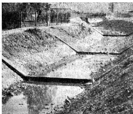
5. Prahová korekcia na bystrine Stošičanka — horná časť úpravy. Medzi prahmi sú nepravidelné nánosy drobných splavenín
