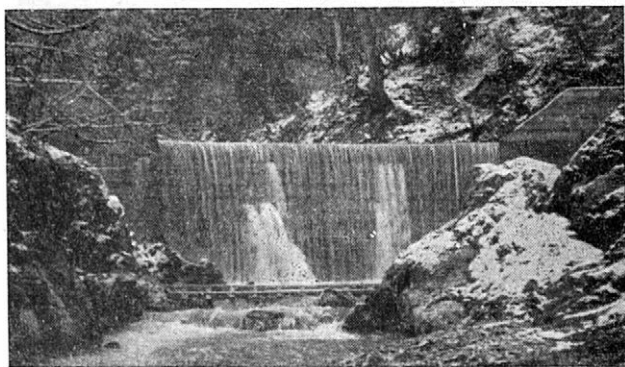
6. Klenbová přepážka na Vadičovce při zvýšeném průtoku. Snímek Škopek
