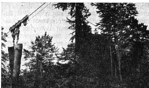
9. Skúšky lanovky DPL pre približovanie v zvislej polohe. Približovanie bukových výrezov lanovkou Pirin.
