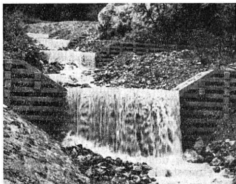
8. Stupně z prefabrikátů
