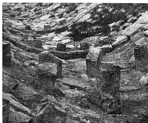
3. Zdrsnenie koryta kynety pomocou viacerých rozrážáčov na bystrine Kozinec ústiacej do prehrady Lipovec
