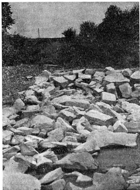
2. Detail sklzového stupňa s účinnou drsnosťou pokusne sledovaný na štrkonosnej rieke Stonávka
