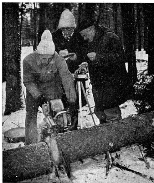
10. Měření vibrací pily Solo-Rex při svislém přeřezávání smrku
