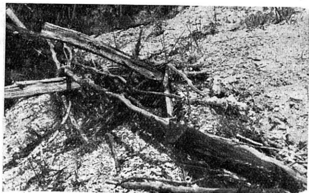
6. Najčastejšia forma poškodenia plôtikov — prevalenie a zasypávanie. Foto Midriak.
