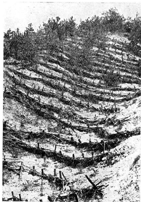
2. Celkový pohľad na plôtikové terasy vo zvlnenom teréne. Foto Midriak.
