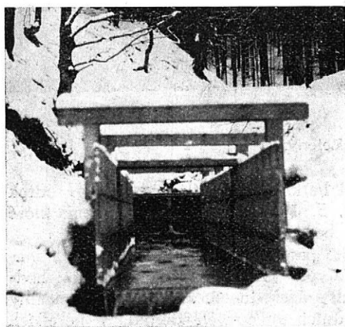
7. Jeden z měrných žlabů na Kamenitém potoce.
