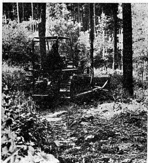
8. Stavba jednoduché vyklizovací svážnice vlastním Zetorem 35 s dozerovou radlicí.
