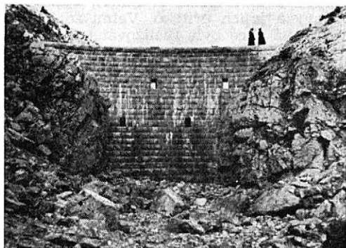
1. Přepážka na bystřině Dulibě z doby působení českých bystřinářů v Dalmácii před první světovou válkou. Snímek Buček
