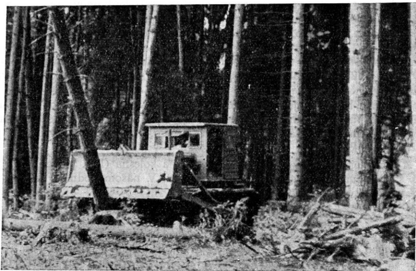
3. Vyvracanie celých stromov buldozénom — navrátenie stromu zdvihnutou buldozérovou radlicou.
