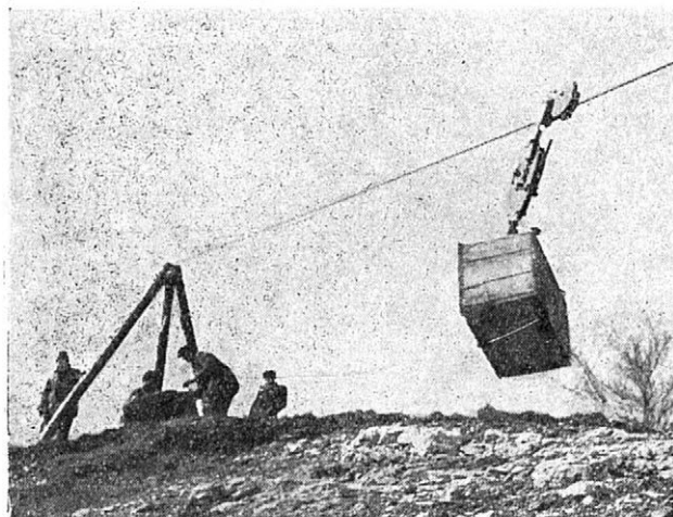
3. Modifikácia lanovky DPL u na dopravu zeminy.
