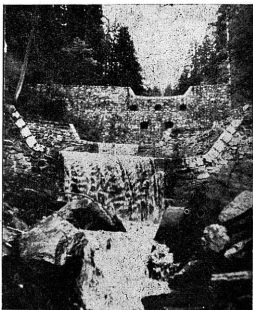
3. Walsenbach (Kitzbühel). Vyprazdňovací kamenná přepážka jako horní uzavírací objekt souvislé úpravy (snímek Čížek).
