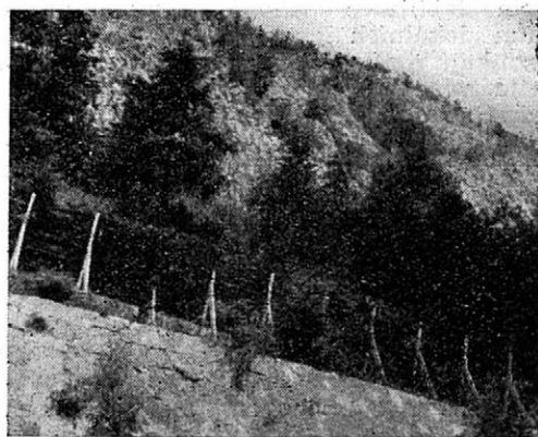
8. Trauenkirchen (Ebensee). Protilavinové zábrany z vyřazených praučů sloužící současně k ochraně silnice Gmunden-Bad Ischl před pádem kamenné sutě (snímek Cízek).
