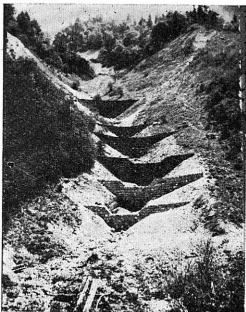
2. Sulzbach — pravostranný přítok Kesselbachu (Ebensee). Zahrazení bezvodé strže soustavou drátokamenných přepážek (snímek Jařabáč).
