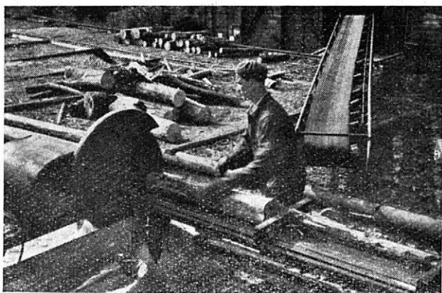
6. Skracovačka s úpravou pre triedenie sortimentov — drevosklad Dětrichov u LZ Bruntál.
