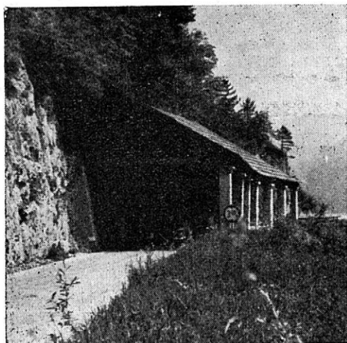
9. Trauenkirchen (Ebensee). Galerie nad silnicí Gmunden - Bad Ischl (snímek Čížek).
