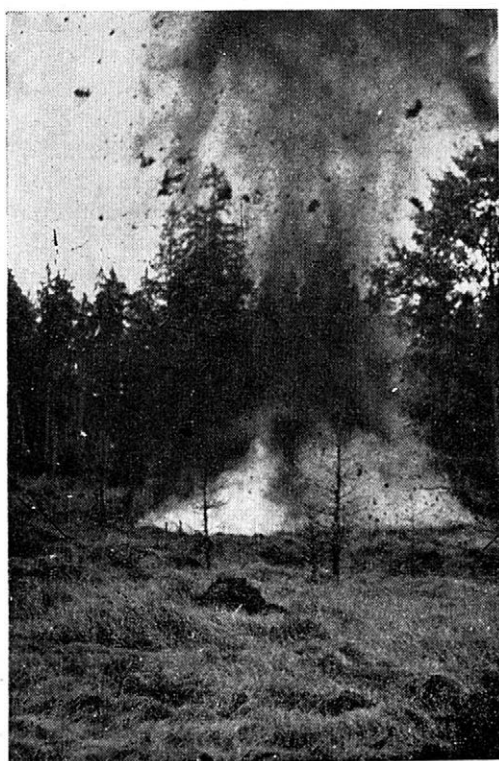
1. Hloubení příkopů trhavinami
