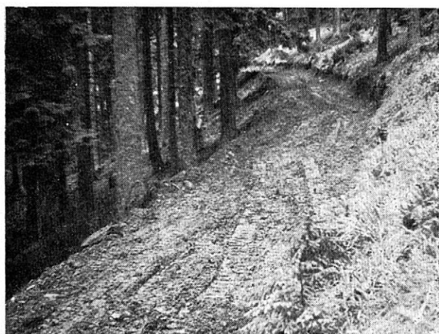
1. Výrazně příčně se vyrovnávající zemina při stavbě svahové cesty o šířce 4 m. Práce dozeru „na hrubo“
