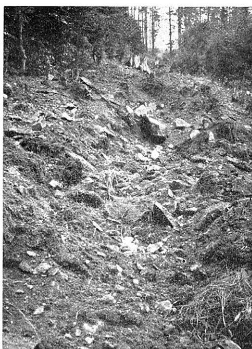
14. Nastřelený profil v zemině těžce kopné Snímky Adámek
