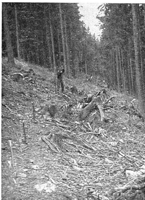
13. Hloubení záhlavních děr ručně železnou tyčí
