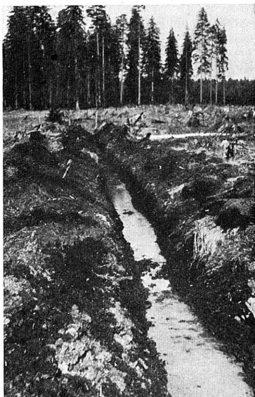
2. Odvodňovací příkop vyhloubený trhavinami. Snímky Ferda
