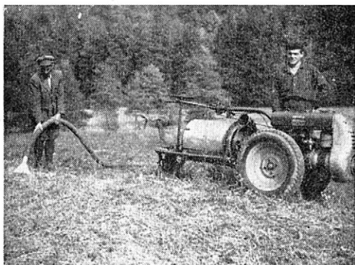
1. Funkční model vysavače na motorobotu PF-6
