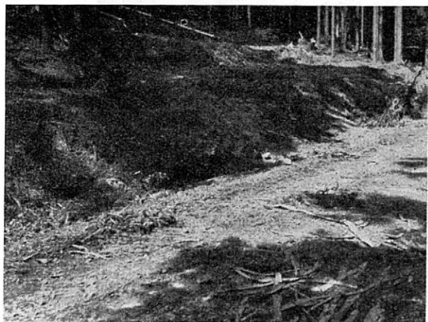
2. Úprava skládky s vyústěním přibližovací linie
