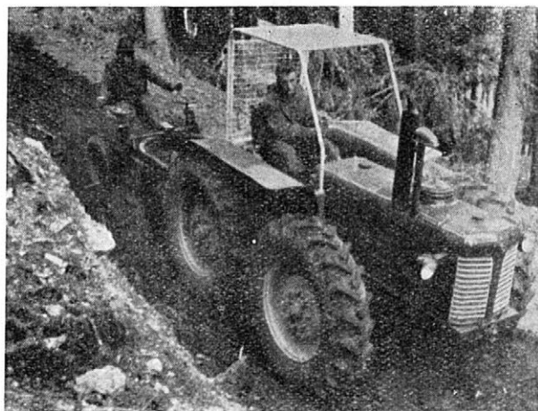
18. Dočišťování pláně neseným srovnávačem
