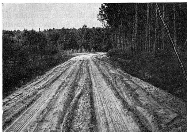
7. Rozprostřený materiál pro stabilizaci na lesní cestě „Vývratská“
