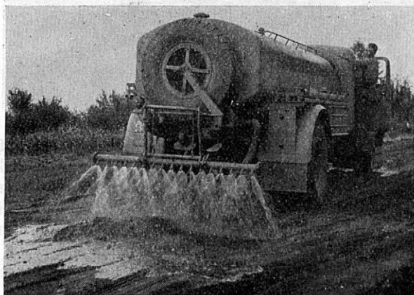
9. Vlhčení směsi na optimální vlhkost
