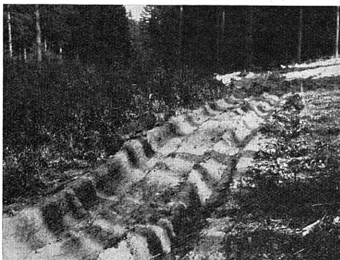
2. Přibližovací linie vedená nejnižším místem v terénu je ještě v březnu silně zbahnělá a málo schopná provozu (LZ Pozoříce, státní poleší Lhotky)
