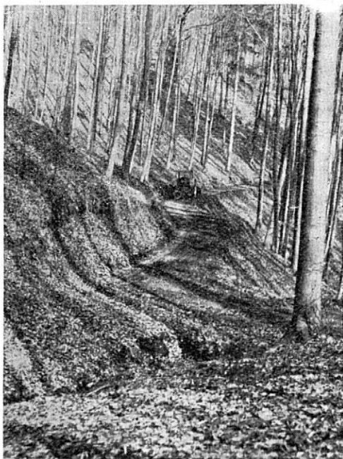
6. Sezónní údržba svahové přibližovací cesty neseným srovnávačem
