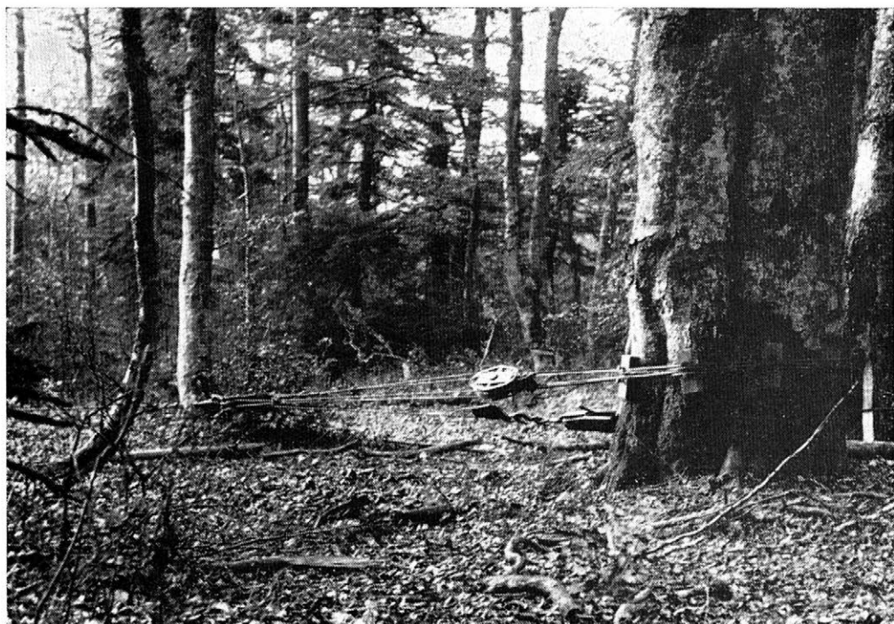
11. Napínání vyklizovací lanovky pomocí kladky.
