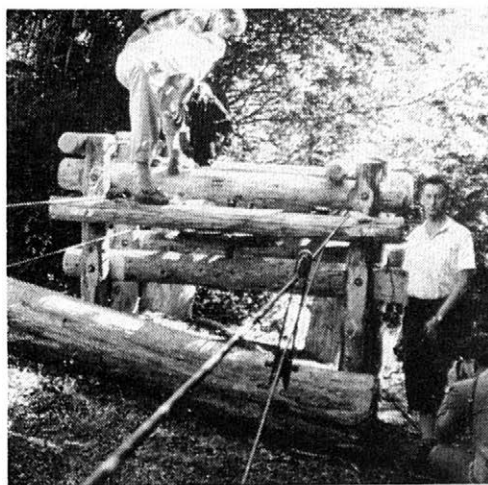
10. Kotvení nosných lan lanovky Valtelina přímo na brzdnu věž (Itálie).
