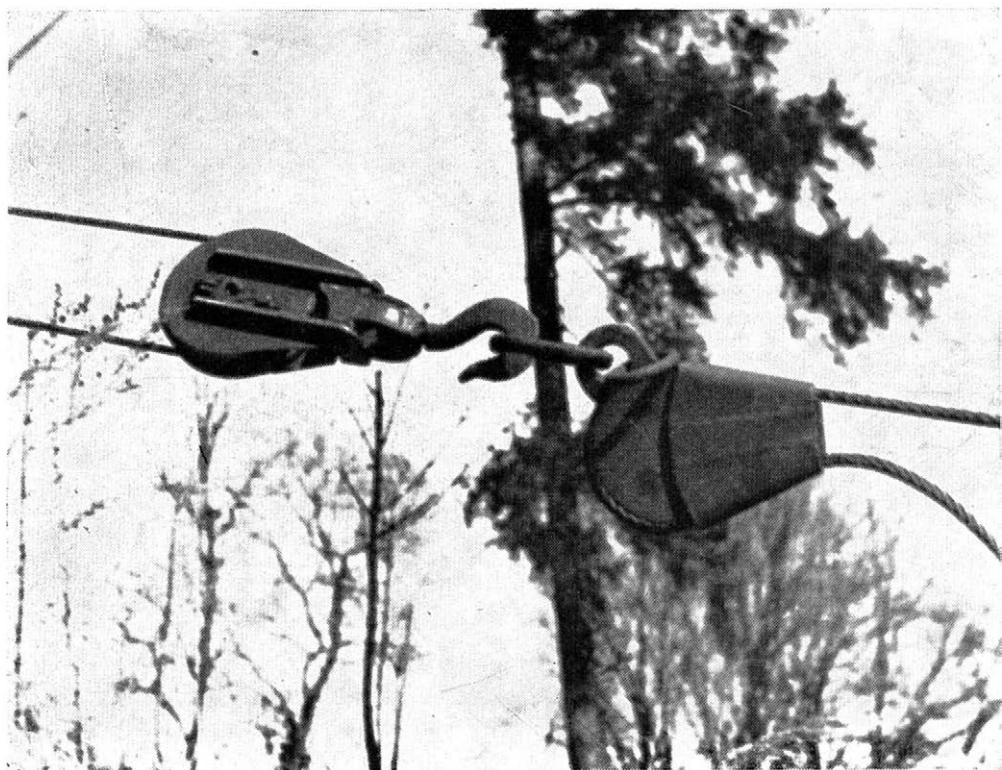
8. Kotvení a napínání vyklizovací lanovky pomocí volné kladky a klínové spony.
