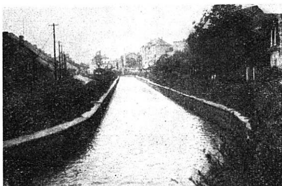
5. Úprava Veličky v Hranicích
