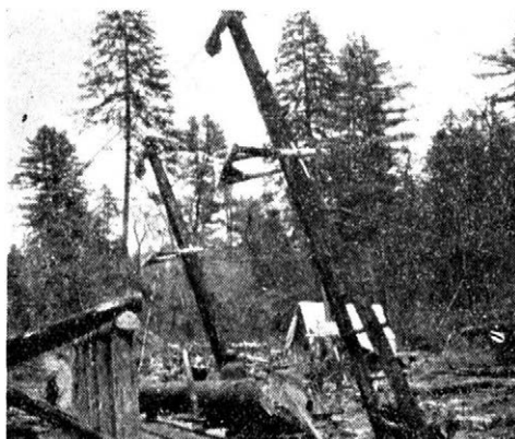
Obr. 5. Nakládání dřeva v účastku č. 12 polesí Taj-Ling
