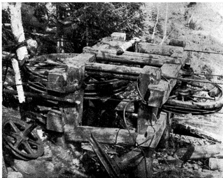
Obr. 2. Třecí lanáče tažného lana lanovky »Vatellina« na horní stanici. Brzdové zařízení je upraveno na levém lanáči
