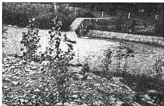
Obr. 1. Biologické i technické zpevňování břehů bystřin je důkazem dobré péče o hospodaření s vodou. Foto Ing. Pělucha, LTM-HB Ostrava
