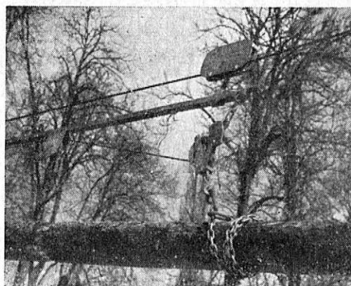
Obr. 3. Přibližování jednobubnovým navijákem. Smysl dopravy po i proti svahu. Kmen je uchycen v horizontální poloze visutým způsobem. Přední část kočky.
