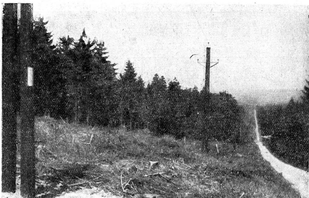
2. Nově vybudované vedení vn podél vývozní cesty, takže se podstatně snížila odlesněná plocha průseku.
